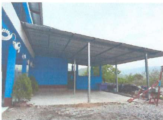
Foto1: CUBIERTA DE LÁMINA
