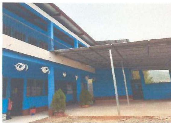
Foto 2: CANALES Y BAJADAS DE AGUA PLUVIAL
